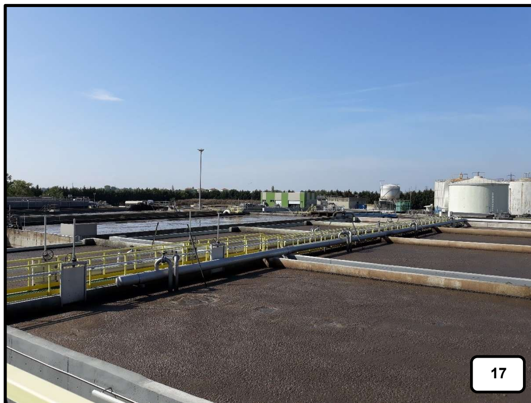
Figura 108: Vasca di ossidazione linea 1
