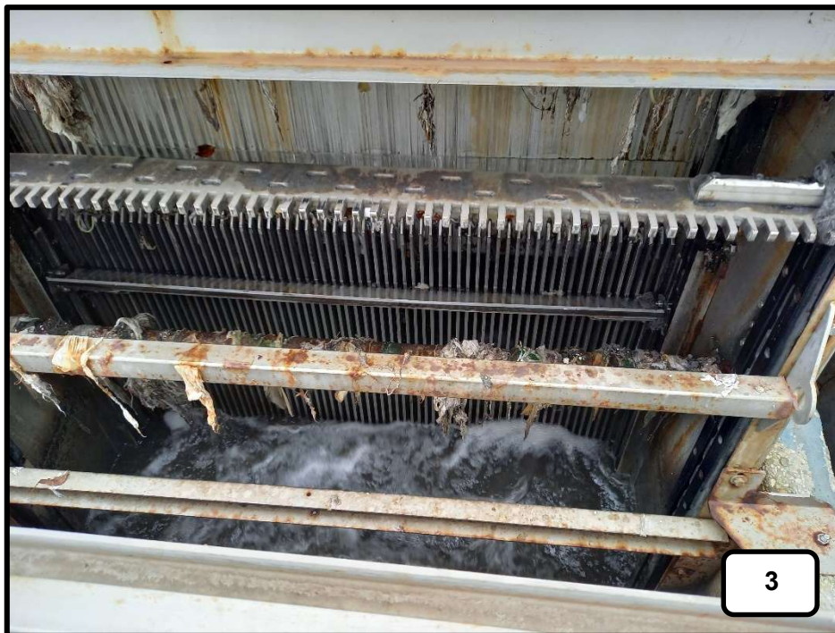
Figura 4: Sezione di grigliatura grossolana
