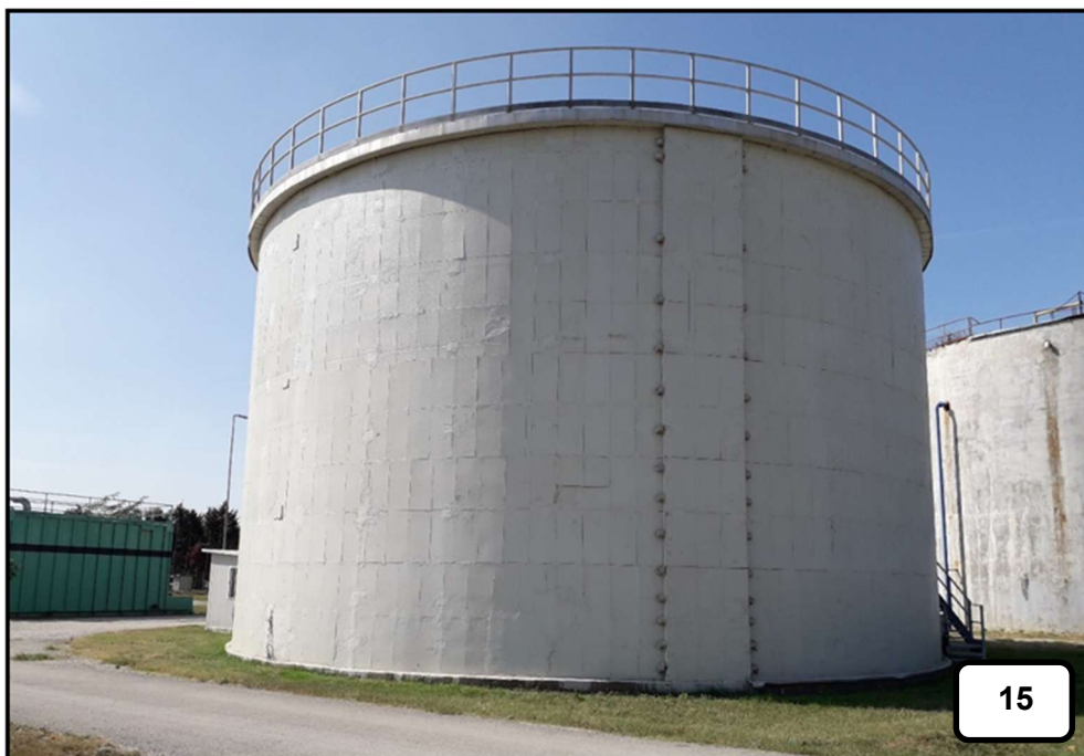
Figura 16: Digestore anaerobico 1
