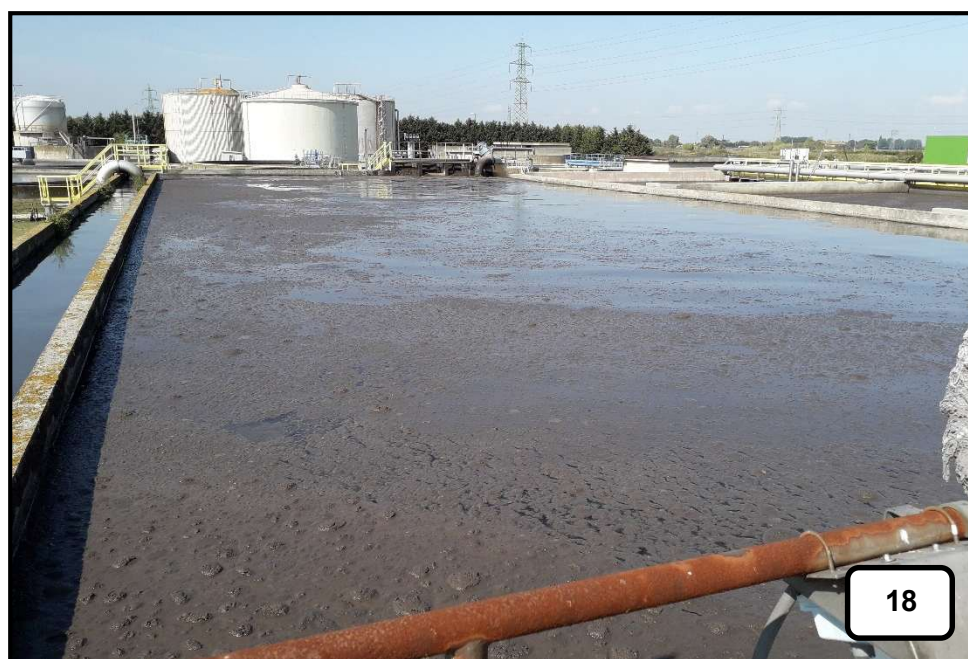
Figura 19: Vasca denitrificazione linea 1
