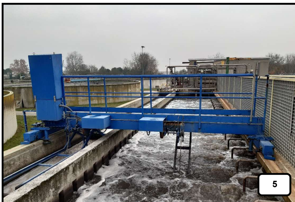
Figura 6: Vista di uno dei due canali di dissabbiatura aerata
