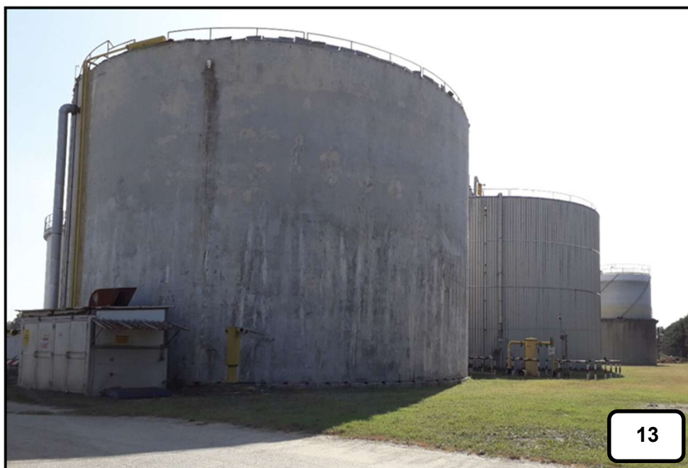
Figura 14: Digestori anaerobici 1 e 2 e gasometro
