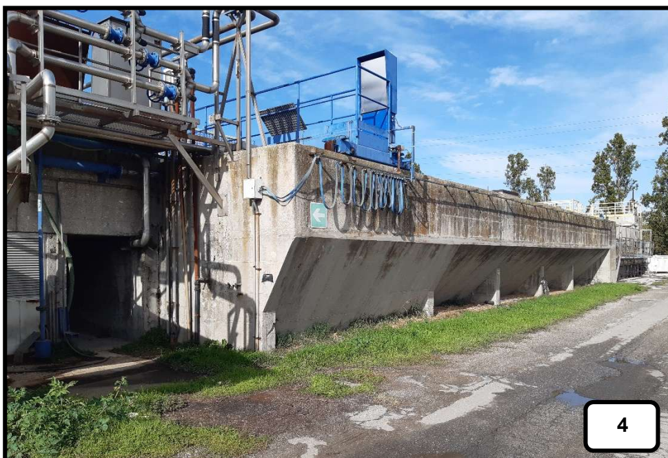
Figura 5: Vista laterale da piano campagna dei canali di dissabbiatura aerata con disoleatura
