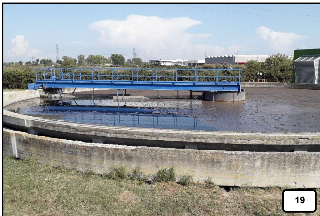
Figura 20: Sedimentatore secondario 5 linea 1
